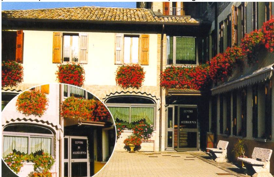
Centro di Accoglienza: la struttura dopo il 1° ampliamento
